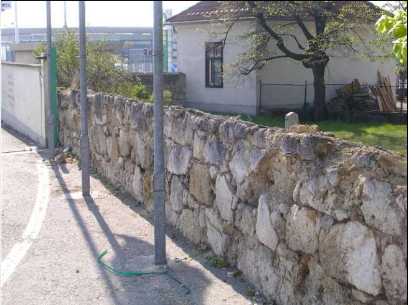
Bild 9: Nordmauer (außen) im Einfahrtsbereich (Blick nach O)
