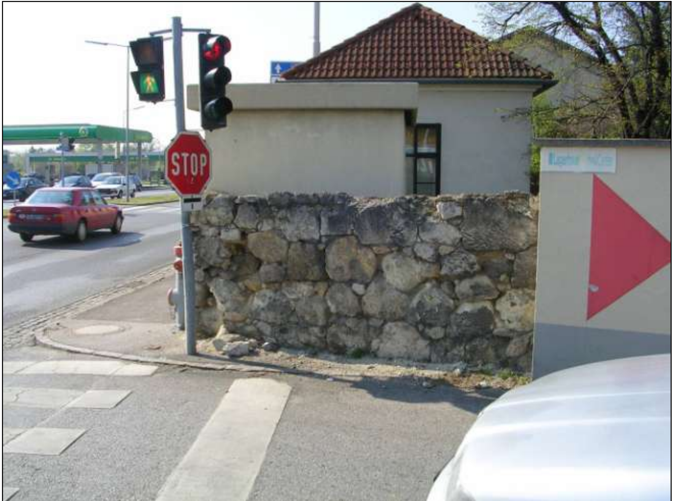
Bild 7: Nordmauer (außen) im Kreuzungsbereich
