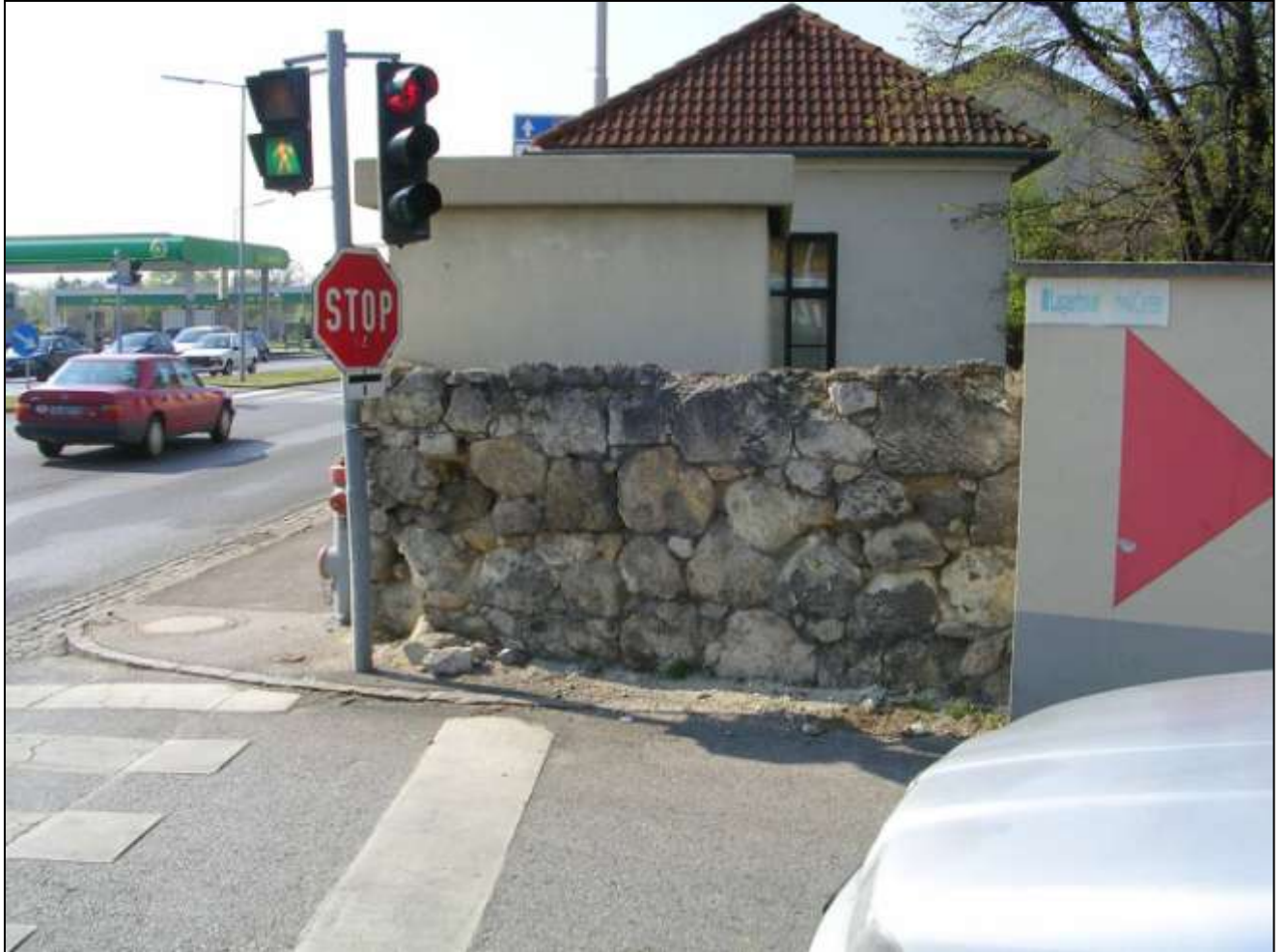
Bild 7: Nordmauer (außen) im Kreuzungsbereich
