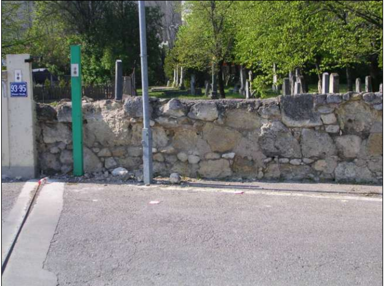
Bild 8: Nordmauer (außen) im Einfahrtsbereich
