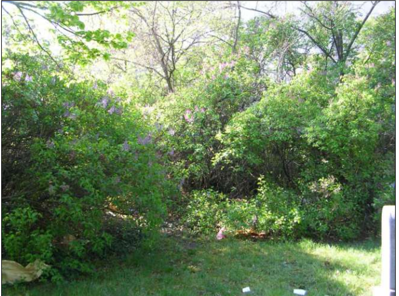
Bild 41: Südost-Ecke (massiver Bewuchs, Verunreinigungen)
